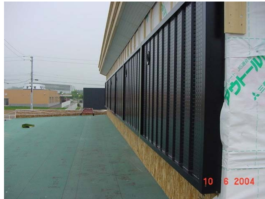
ソーラー パネル取り付け完了
