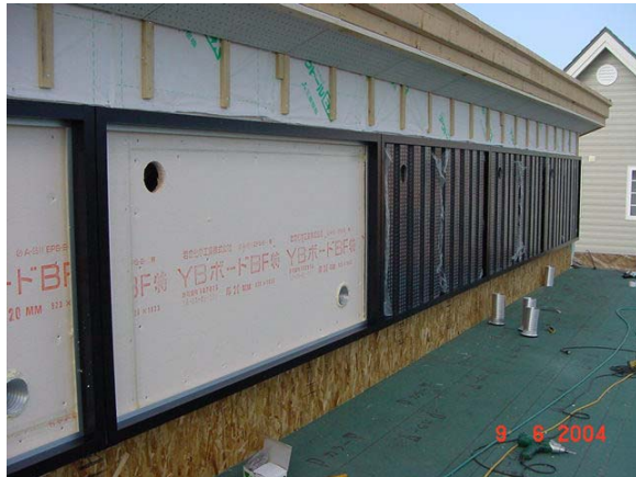
外気導入口 2階小屋裏軒天付近
