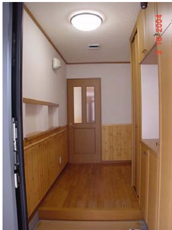
天井吹き出しファン 塩ビ管スタイロ巻きダクト
