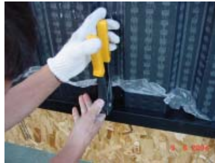
ソーラー パネル取り付け リベット止め
